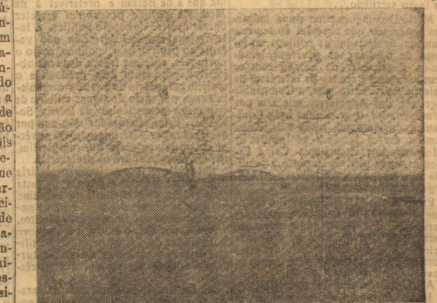
ponte sobre o rio Coima
